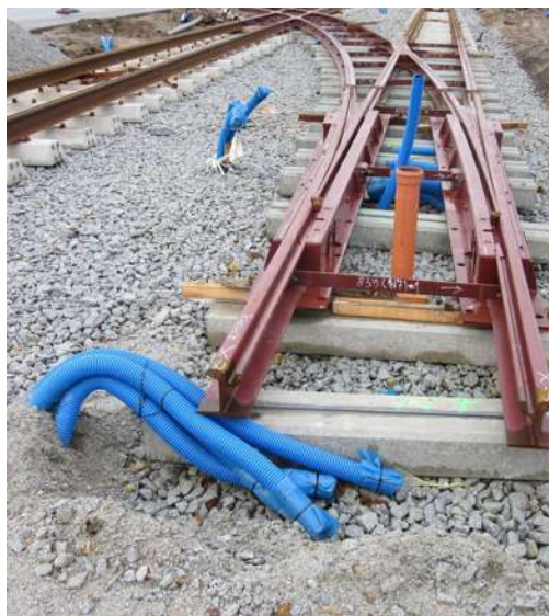
Na przebudowywanej drodze miejskiej czeka na geodetów inwentaryzacja urozmaiconego uzbrojenia technicznego terenu
