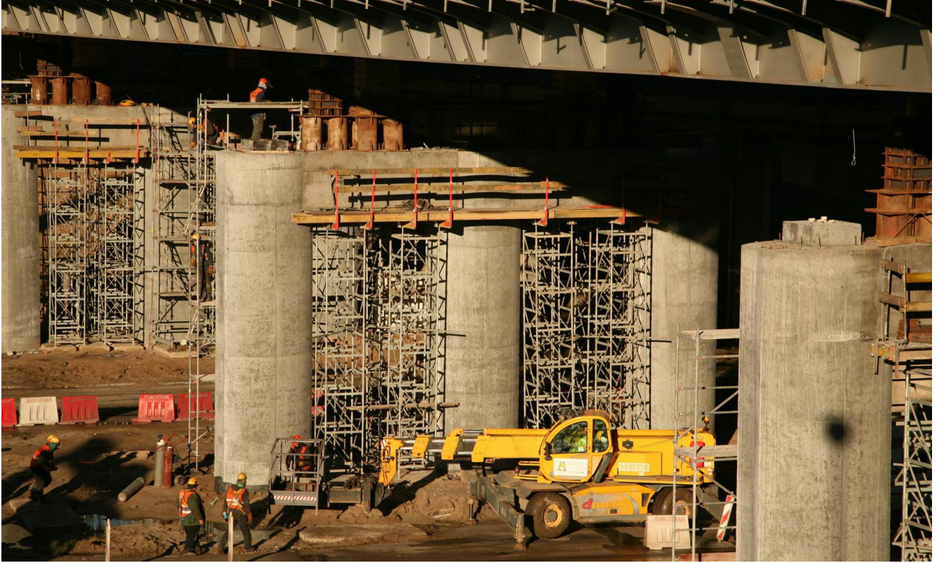
Wiadukt w ciągu Alei Wojska Polskiego nad Aleją Jana Pawła II: powyżej ustrój nośny ustawiony na siłownikach; poniżej podpory z siłownikami, na których spoczywa ustrój nośny; u dołu ustrój nośny opuszczony na podpory wiaduktu.
