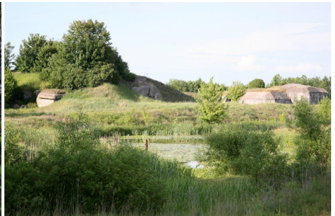
Betonowe umocnienia twierdzy Osowiec
