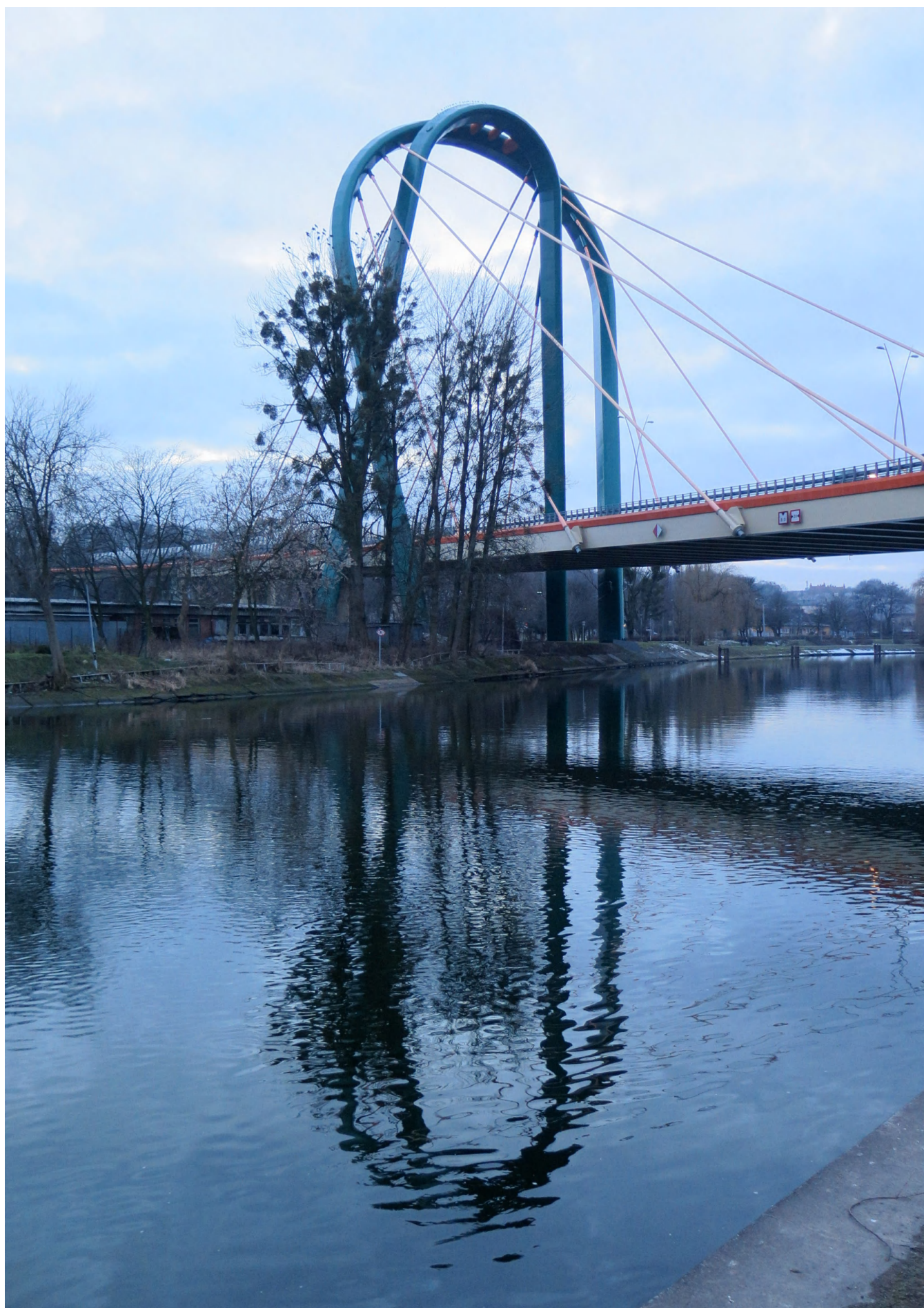
Most linowy przez Brdę w Bydgoszczy, w ciągu trasy uniwersyteckiej ...
