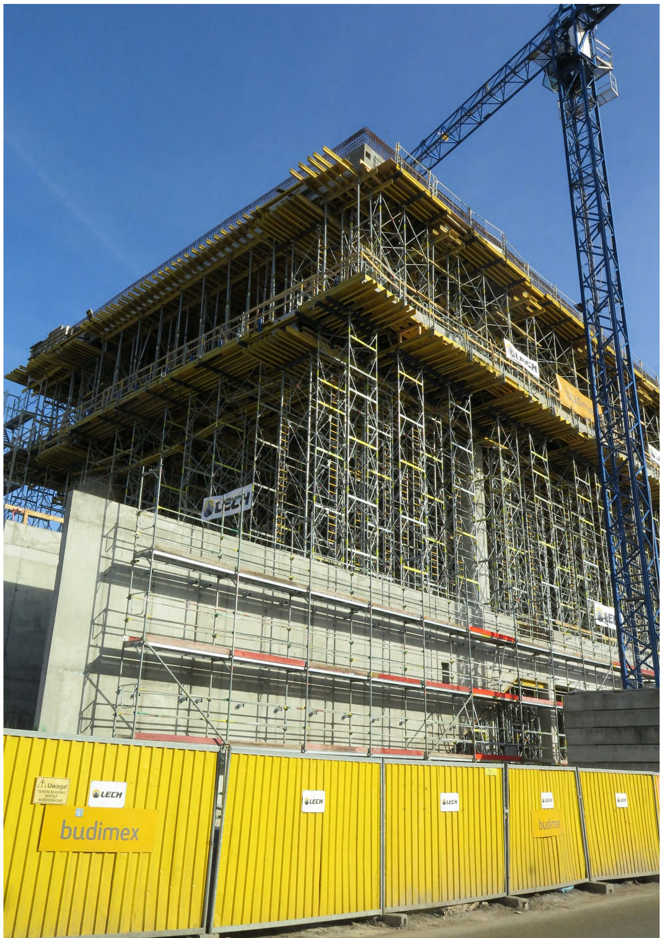
... bryła nowego dworca kolejowego w Bydgoszczy, w rusztowaniach ...
