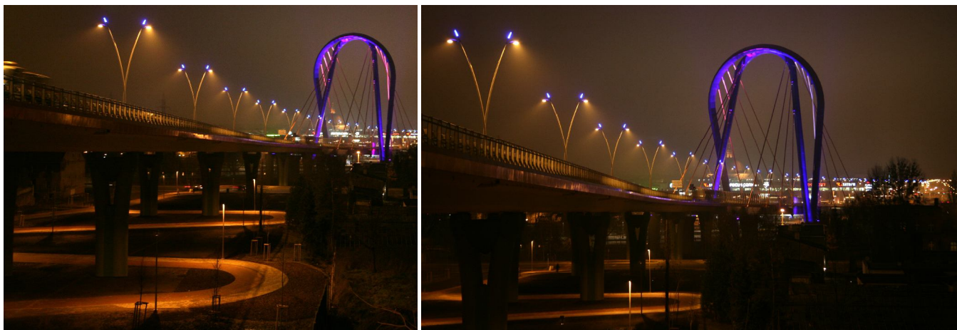
... serpetynowa ścieżka dla pieszych i rowerzystów, pod południowym odcinkiem estakady ...
