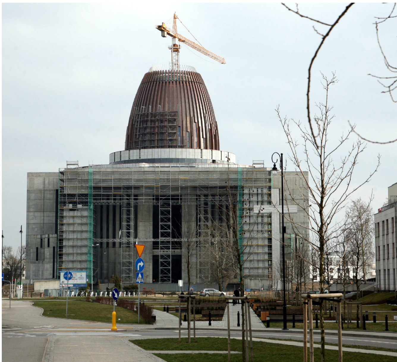
Świątynia Opatrzności Bożej na warszawskim Wilanowie nadal pozostaje w budowie ...
